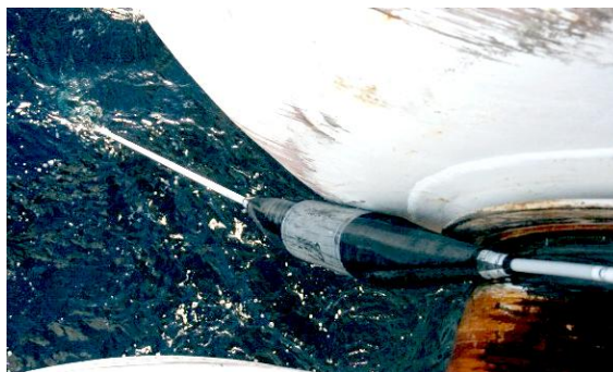
センサーケーブル設置
